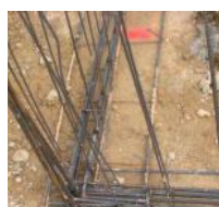
Nœud de chaînage - Continuité mécanique
