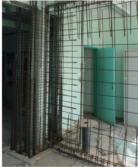
Exemple de renforcement parasismique
