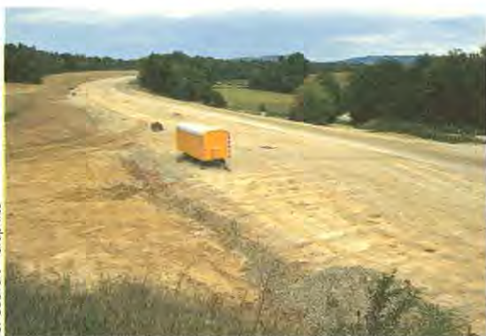
L'autoroute A39 en chantier.
