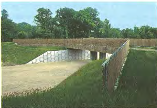
Passage pour la faune sur l'autoroute A39 en chantier.
